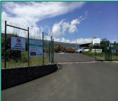
Transit et broyage de déchets verts de Saint-Leu
